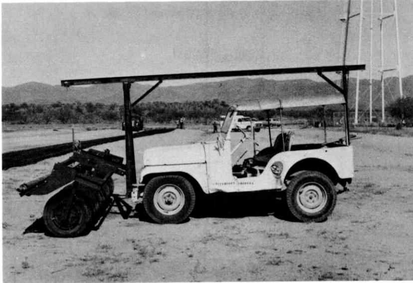
FIGURE 13. SIDE VIEW OF JEEP MOUNTED PLASTIC DISPENSER ROLLER
