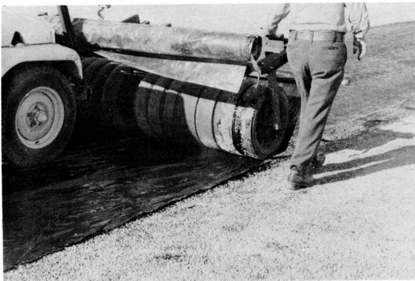
FIGURE 14. JEEP-MOUNTED PLASTIC DISPENSER-ROLLER IN OPERATION
